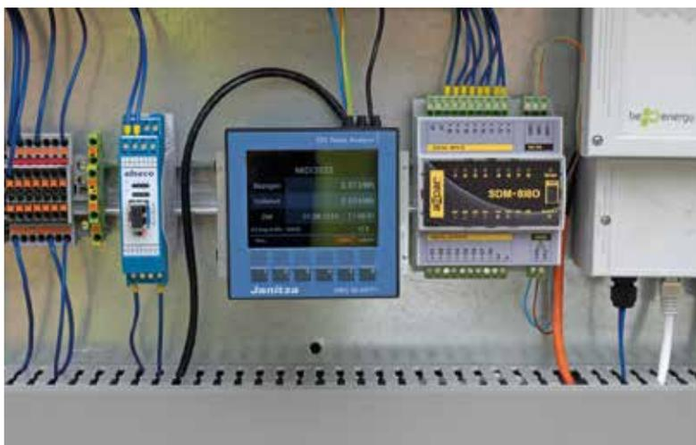
Der Netzanalysator UMG 96-PA-MID+ in der Trafostation des PV-Parks. Die MID-Zertifizierung nach 2014/32/EU garantiert eine rechtsichere Messwerterfassung.
